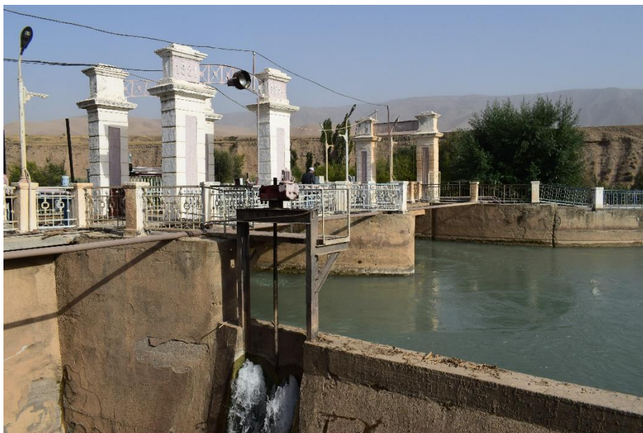
Рис. 5. Сооружение верхнего водозабора на канале Отуз-Адыр речной системы Хуршаб-Сай , сентябрь 2021 г.
