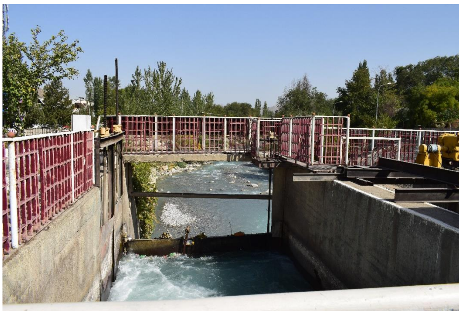
Рисунок 4. Сооружение верхнего водозабора на реке Шахимардан, сентябрь 2021 г.
