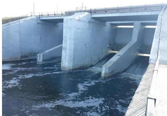
Сегментные затворы Защитной дамбы вид с нижнего бьефа
