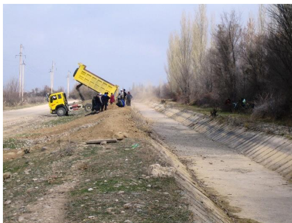
Выполнение ремонтных работ и работ по техобслуживанию на межхозяйственном канале в Таласской области
