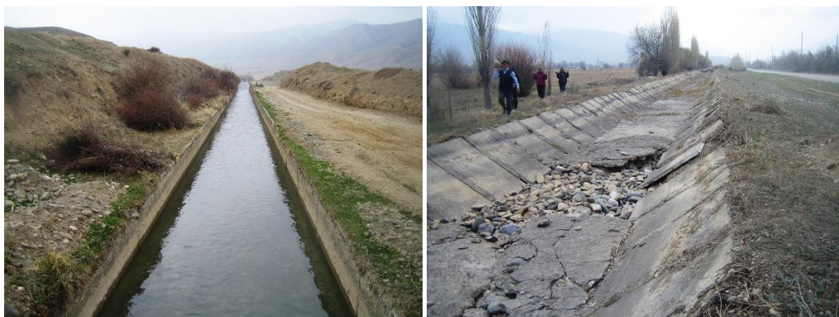
Межхозяйственный канал в очень хорошем состоянии (слева) и в очень плохом состоянии (справа)
