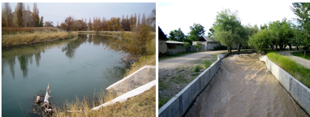
Нереабитированный межхозяйственный канал в Чуйской области (слева) и реабилитированный межхозяйственный канал в Жалалабадской области (справа)
