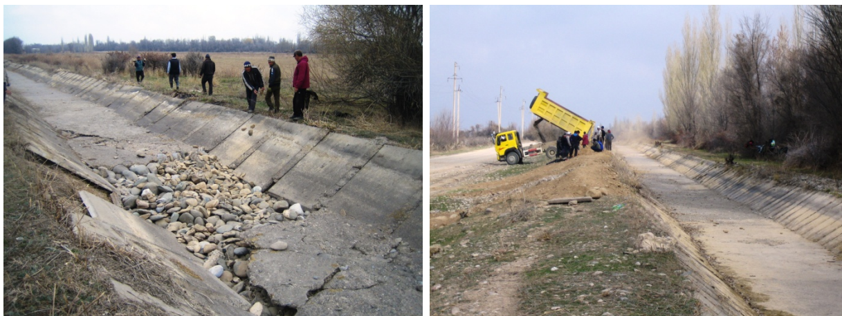
Проведение ремонтных работ на межхозяйственном канале в Таласской области
