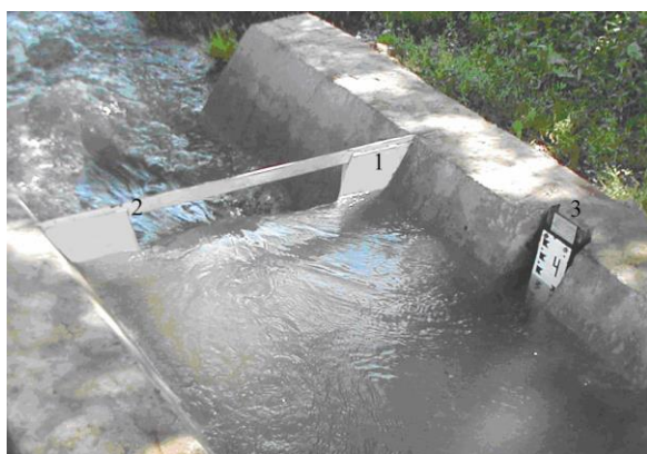
Рис.3. Водослив Чиполетти (вид с верхнего бьефа):
