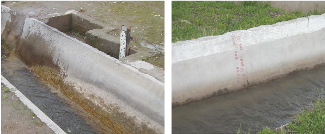
Рис. 7. Градуированный параболический лоток: а) с успокоительным колодцем и уровнемерной рейкой; б) с расходомерной шкалой на откосе лотка
