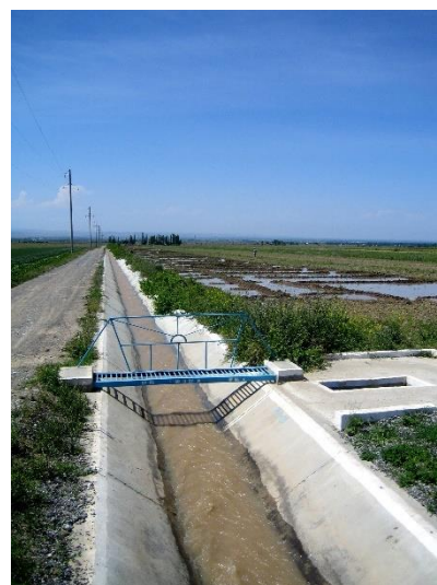
сооружение измерения расхода воды в Чуйской области (слева) и Джалал-Абадской области (справа)
