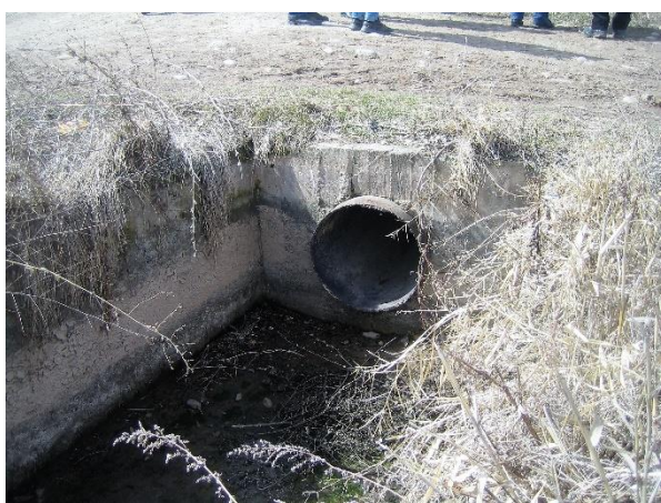
водопропускная труба в Чуйской области
