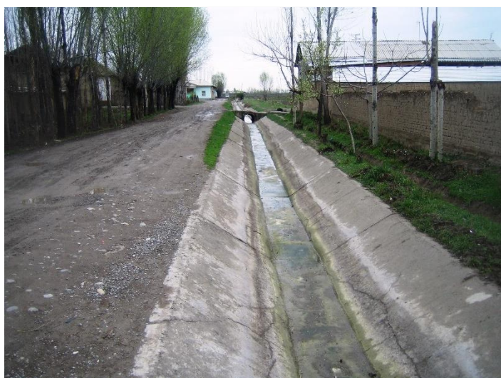
трапецидальный облицованный канал в Ошской области
