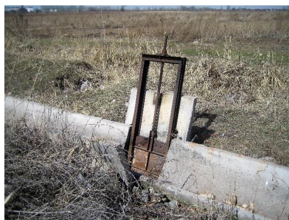
водосброс с затвором с в Чуйской области
