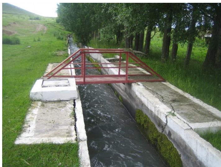
сооружение измерения расхода воды внутрихозяйственного канала в Чуйской области (слева) и Иссык-Кульской области (справа)
