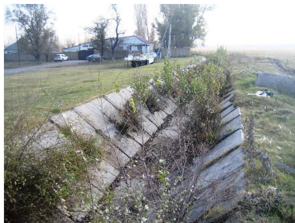
растительность на облицованном канале
