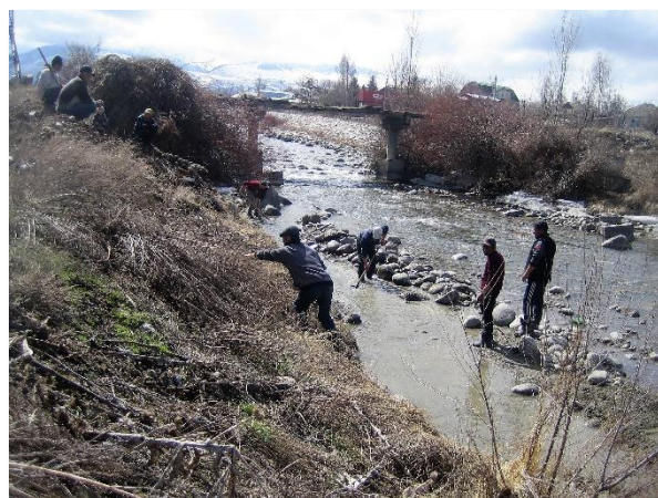
Реконструкция отводной шпоры в руслах рек Ашарным методом в Иссык-Кульской области
