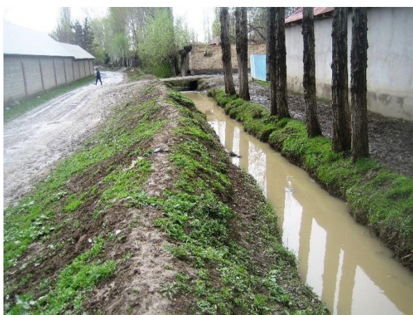
Необлицованные внутрихозяйственные каналы в Джалал-Абадской области
