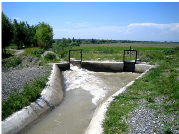
распределительное сооружение в Ошской области
