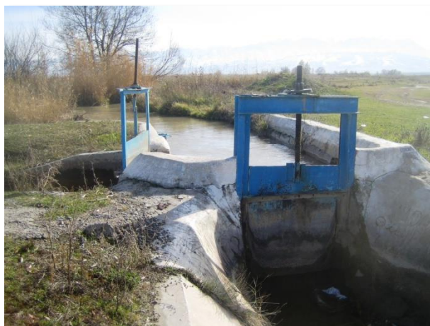
Бесплотинный водозабор в Чуйской области
