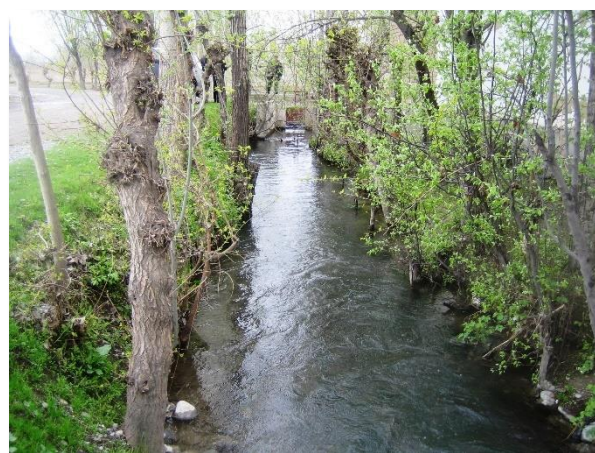
Необлицованные внутрихозяйственные каналы в Джалал-Абадской области
