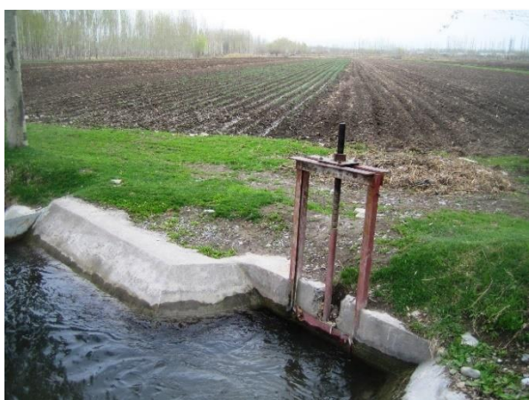
водосброс с затвором в Джалал-Абадской области
