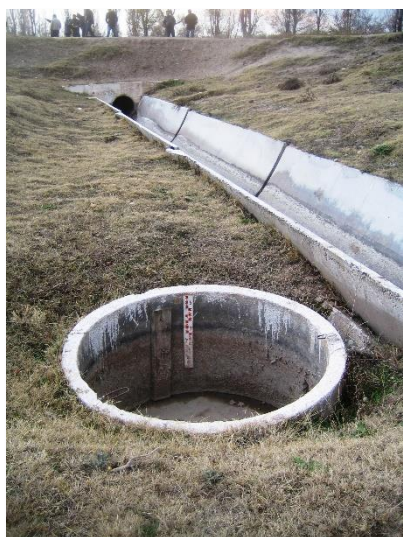
сооружение измерения расхода воды внутрихозяйственного канала в Чуйской области (слева) и Иссык-Кульской области (справа)
