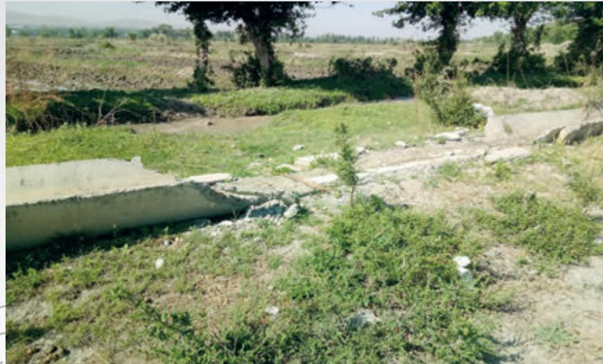
*Разрушенная секция лоткового канала в АВП Бургонду-Суу
