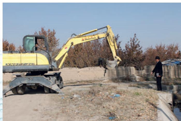
циялоого берилди. Каналдарды бетондоо жана башка гидрокурулмаларды бетондоо иштеринде подрядчик тарабынан бардык курулуш нормалары жана эрежелери сакталып, бетондоо иштери жокорку деңгээлде аткарылды. Жалпысынан каналдын 2950 метр жери монолит бетону менен төшөлүп, ички чарбалык каналдын бетон төшөлгөн бөлүгүнүн суу өткөрүмдүүлүгү 6 м<sup>3</sup>/с жетти.
