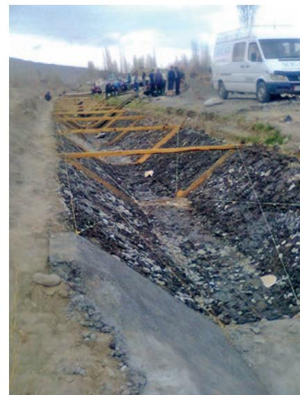
литр күйүүчү май берилип, Ак-Татыр каналынын 3,12 км механикалык жол менен тазаланып, каналды бетондоо иштерине күм шагылдар ташылууда. Ак-Татыр каналынын 500 метр аралыгын бетондоого 90 тонна цемент алышып берилип, бетондоо иштери кызуу жүрүүдө.
