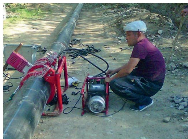
**Бел айыл аймагындагы “Күнгөй” суу откөрүүчү түтүкчөсүндө (дюкер) полиэтилен трубаларын бириктүрүү учуру**
